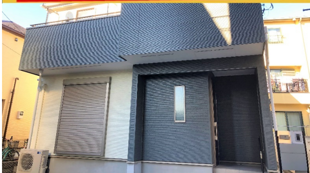
2022年5月外壁塗装、バルコニー防水施工
